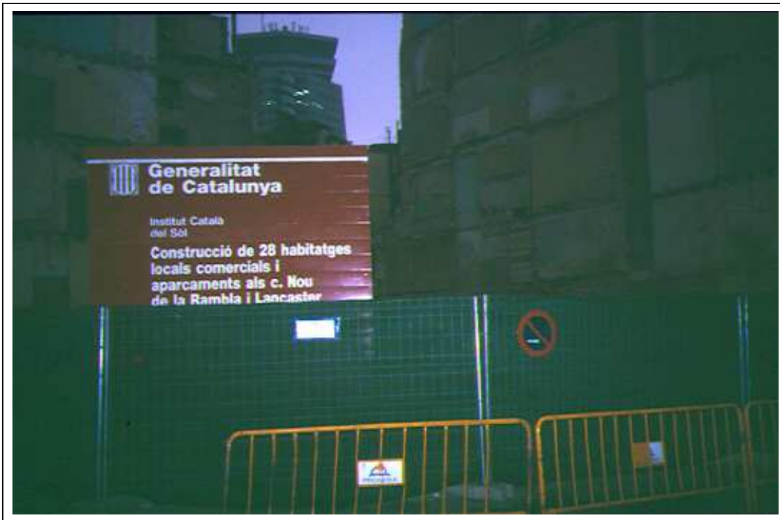
Imatge del solar, amb l'edifici que l'ocupava ja derruït.
