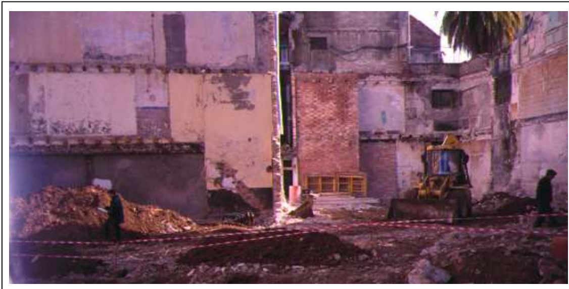
Tasques d'excavació i documentació de la cala de sondeig núm. 2.
